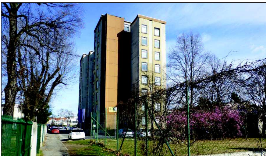
Slika 8: Dijaški dom – trenutno stanje, južna fasada
