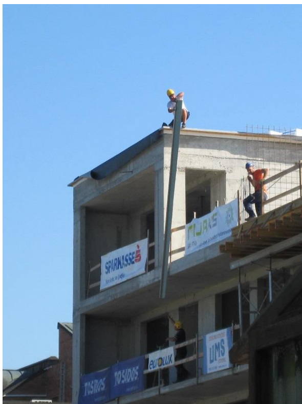
Slika 9: Nezaščiteni robovi objekta in nevarnost padca delavcev z višine
