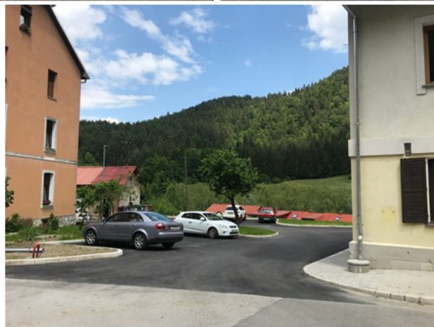
Slike: Preplastitev površin ob stanovanjskih blokkih do restavracije na Poleni
