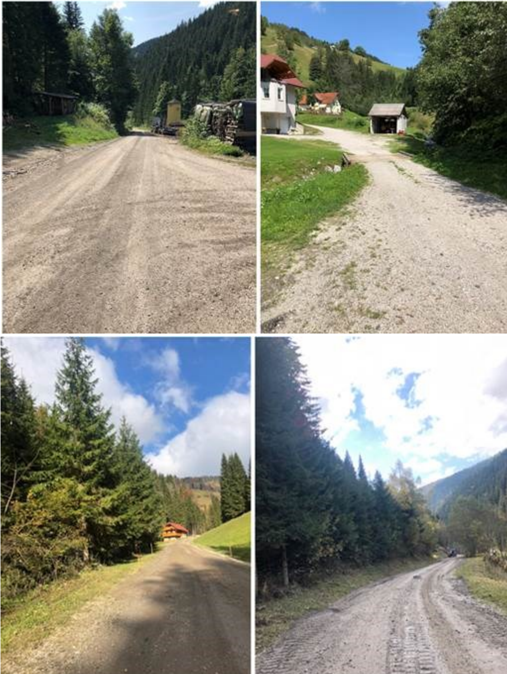
Slike: Preplastitev odseka ceste v Koprivni - Kamnik
