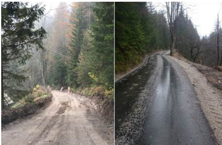
Slike: Preplastitev ceste Jazbina – Jurin
