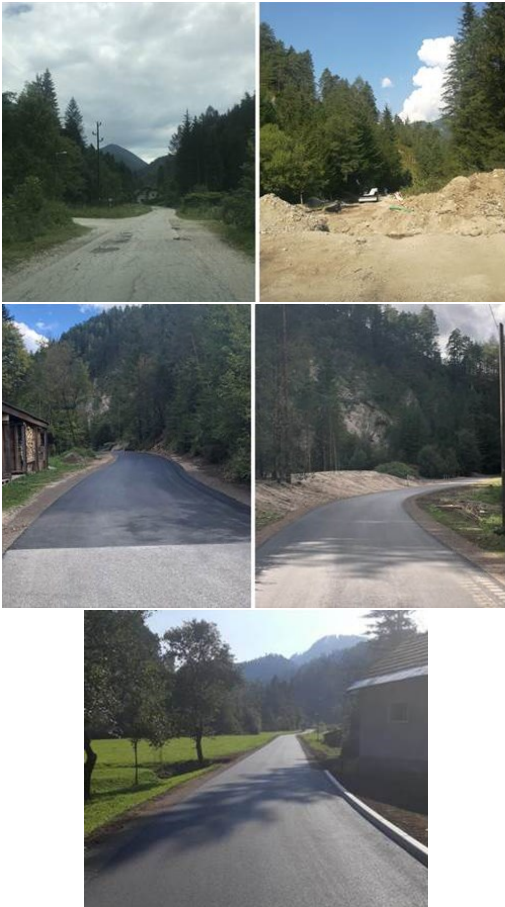
Slike: Preplastitev glavne ceste Žerjav – Jazbina
