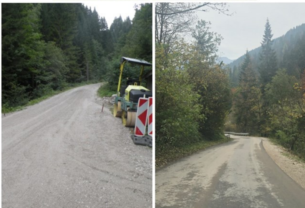
Slike: Preplastitev ceste v Koprivni – Zdovc
