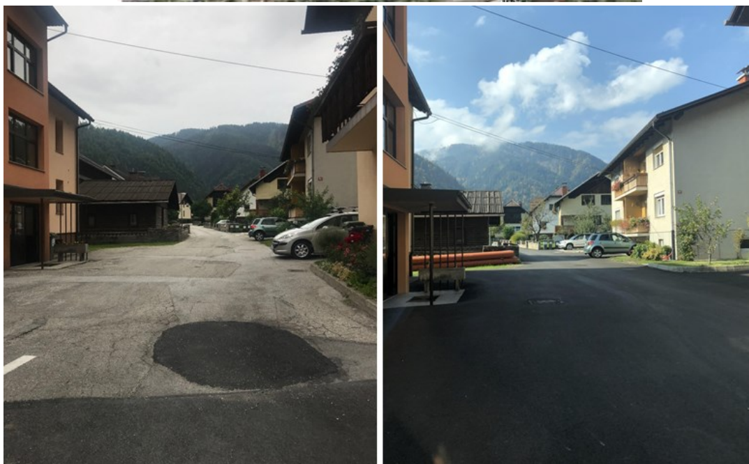
Slike: Preplastitev ceste med stanovanjskimi hišami Center 80
