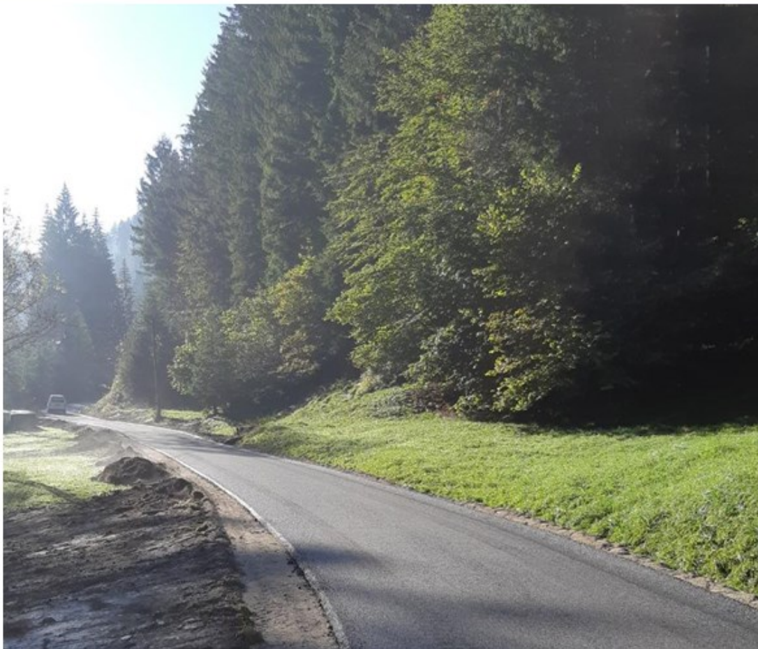
Slike: Preplastitev ceste na Ludranskem vrhu. (Prhanija-Stavba)
