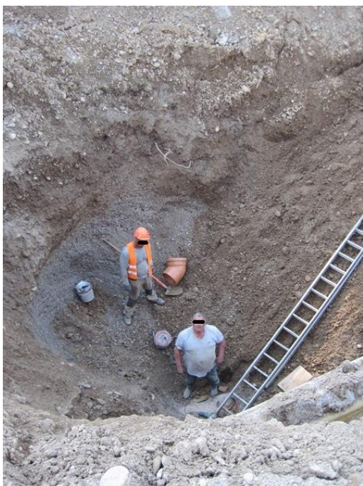
Slika 11: Delavci v nezavarovanem izkopu
