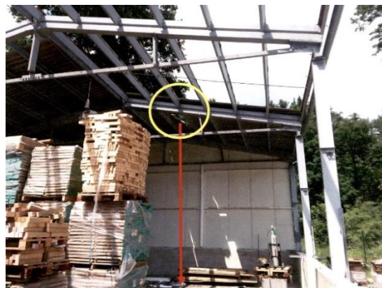
Slika 15: Prizorišče smrtne nezgode, pri kateri je delavec pri prekrivanju strehe stopil na salonitko in padel z višine
