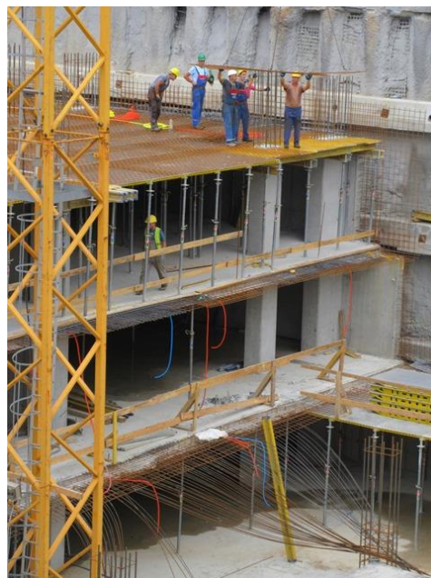
Slika 13: Neustrezno varovanje delavcev pred padci z višine
