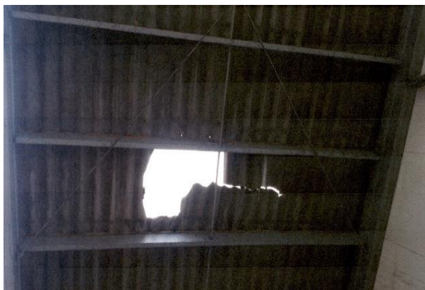
Slika 16: Odprtina v strehi, skozi katero je padel delavec
