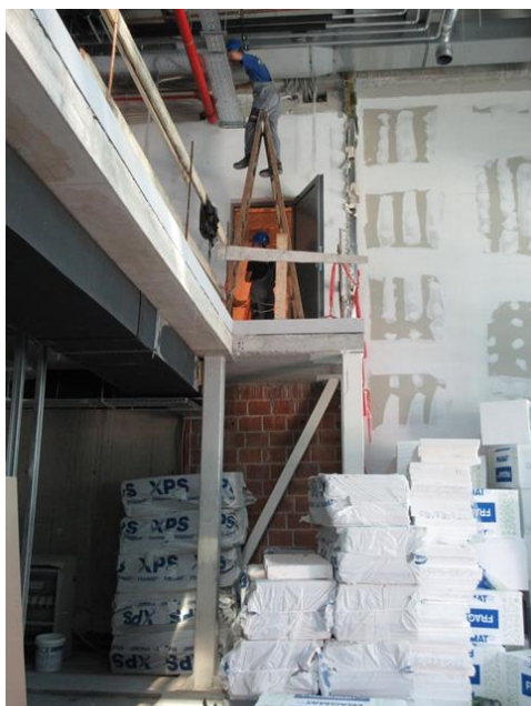
Slika 14: Neustrezno varovanje delavcev pred padci z višine
