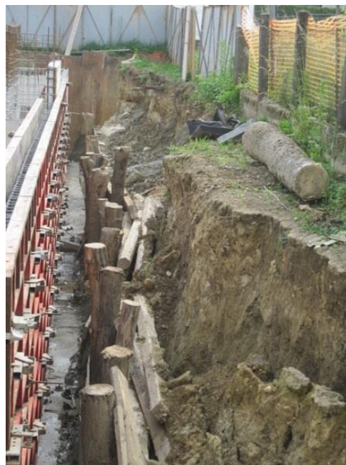
Slika 12: Porušitev brežine ob zavarovanem izkopu
