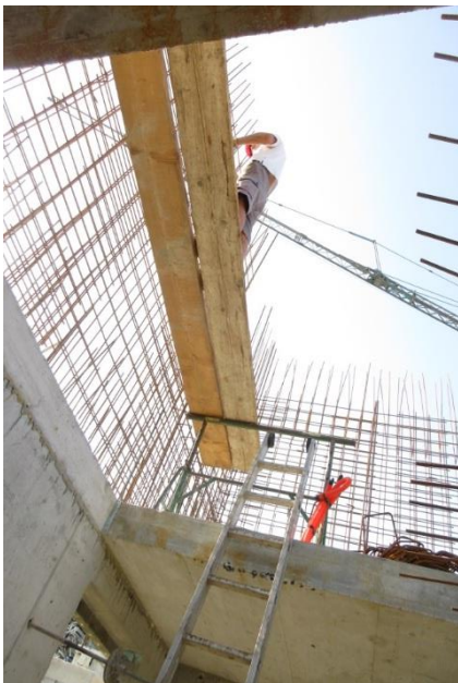
Slika 11: Neustrezna zaščita pred padcem z višine.
