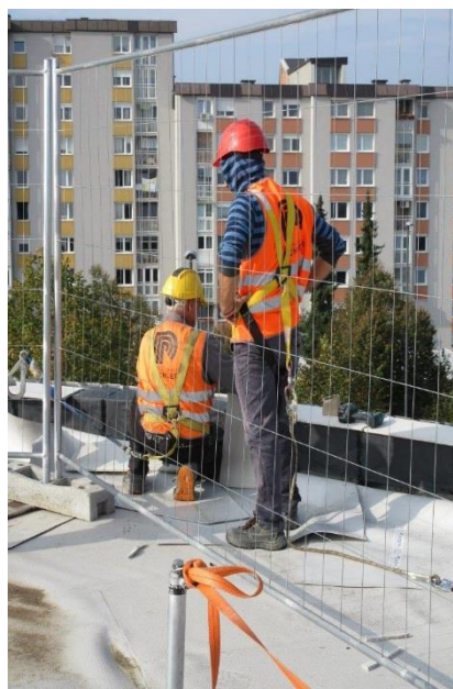
Slika 12: Ustrezna zaščita pred padcem z višine.
