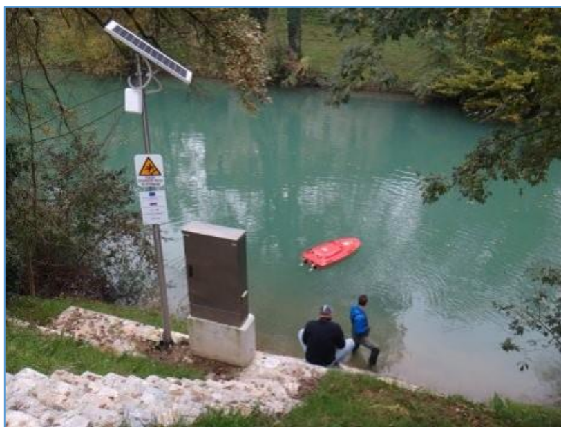
Slika 6. Hidrometrične meritve na hidrološki postaji ARSO.
