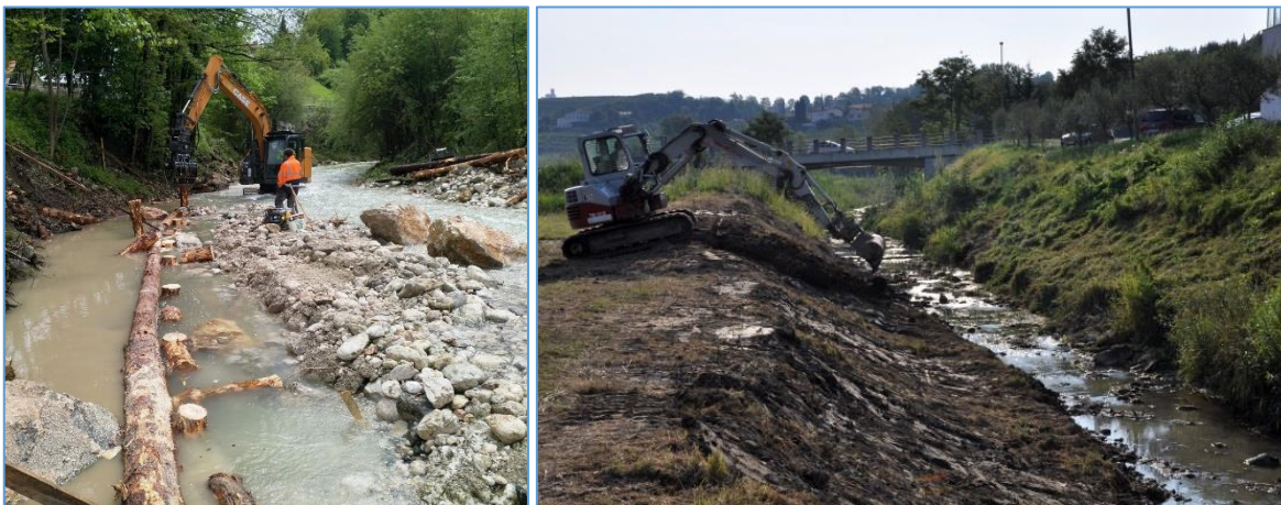
Slika 19. Redno vzdrževanje vodotokov.
